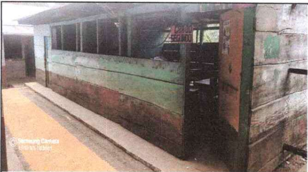
Foto 3: SUSTITUCION DE COLUMNAS Y DE PARED.
