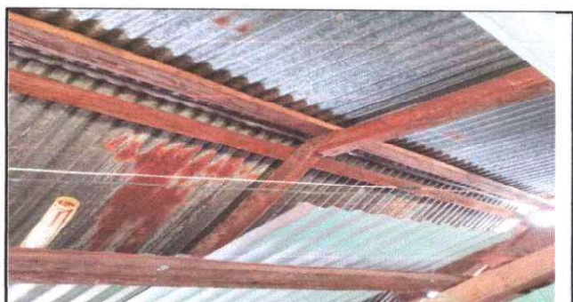
Foto 6: SUSTITUCION DE ESTRUCTURA DE LAMINA.
